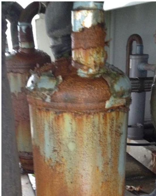
**FIGURE 17:** EXAMPLE OF ADVANCED CORROSION ON OUTDOOR SUCTION RECEIVER
