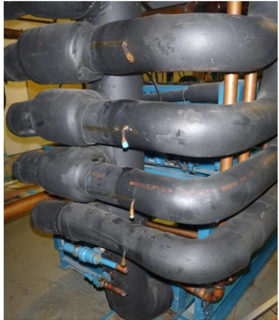
**FIGURE 16:** EXAMPLE OF A COMPRESSION PLANT FEATURING NUMEROUS PRESSURE TAPS
