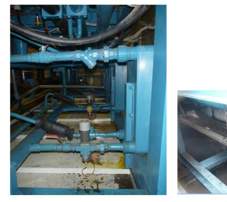
FIGURE 19. PRESENCE OF OIL ON THE GROUND
