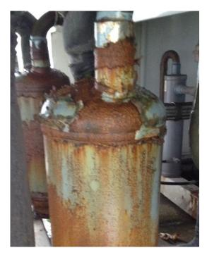
FIGURE 17: EXAMPLE OF ADVANCED CORROSION ON OUTDOOR SUCTION RECEIVER
